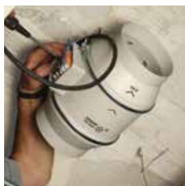
Realizar las conexiones.
