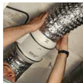
Acoplar los conductos.
