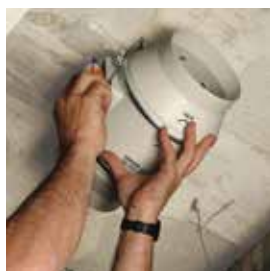
Colocar el cuerpo motor.
